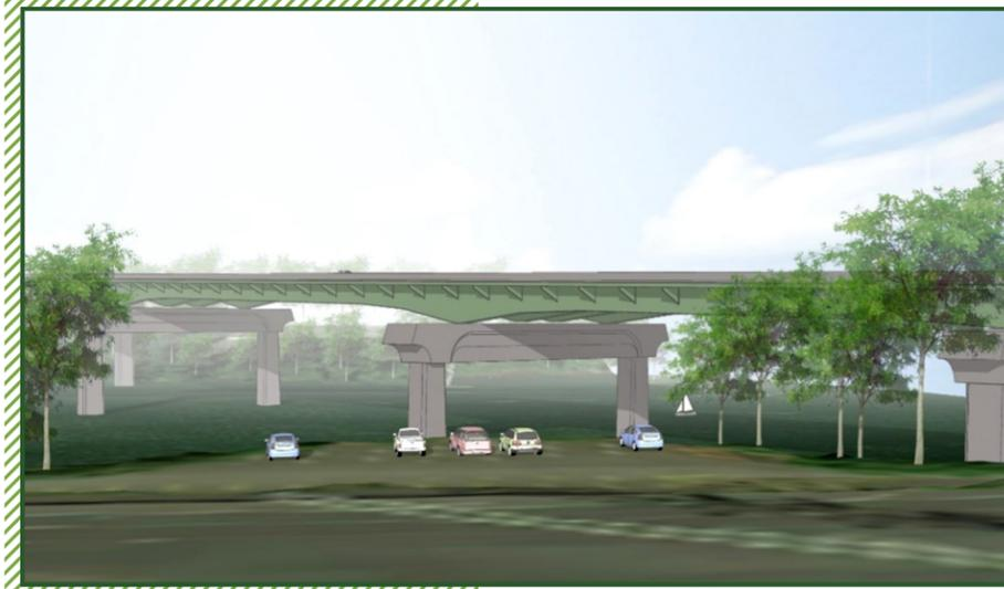
El proyecto mejora el puente Abernethy para que pueda resistir un terremoto de gran magnitud, que se muestra aquí con nuevas columnas reforzadas.
