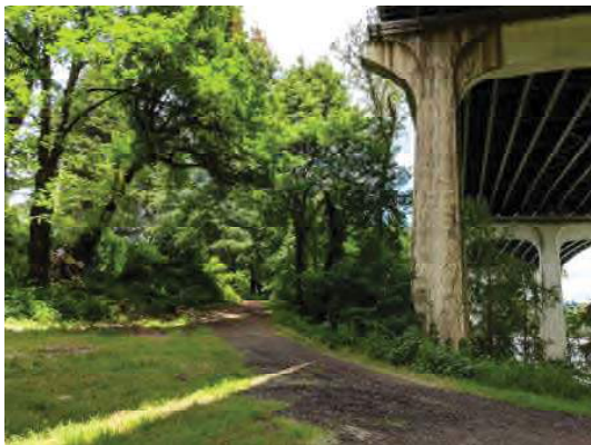
Drip Edge View 2
